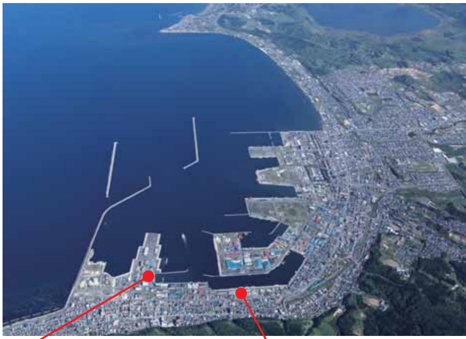
■ 稚内市ポートサービスセンター
