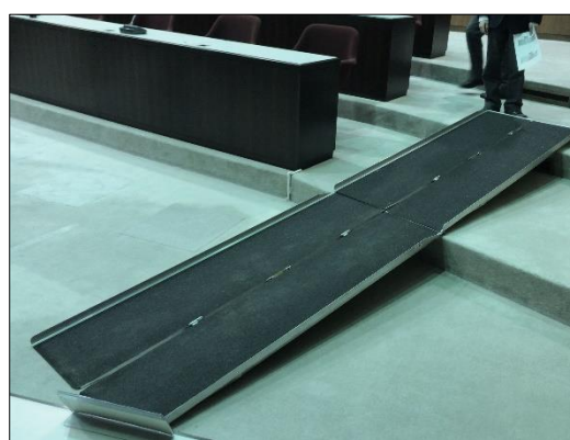
(応急的に設置されたスロープ)
