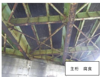
写真-1 損傷例
