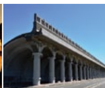
稚内港北防波堤ドーム
