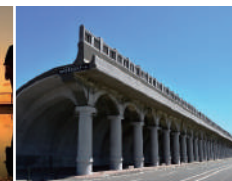
稚内港北防波堤ドーム
