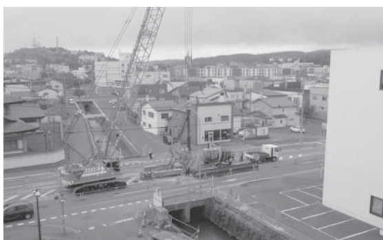
河川工事が進んでいるクサンル川
